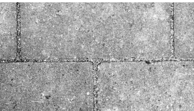
Wirksame Pflasterdecke durch funktionsfähige Fugen
