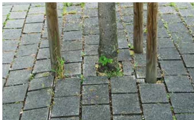
Platzmangel durch Versiegelung der Fläche bis zum Baumstamm
