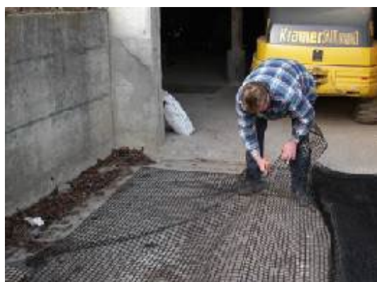
Bild 23: Ablängen der Geogitter
