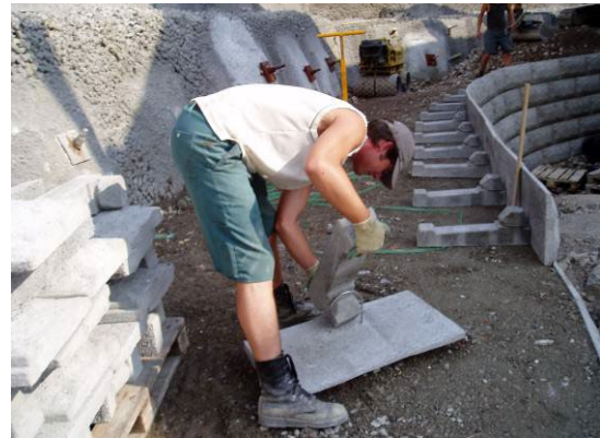
Bild 15: Frontplatte mit Anker verbinden
