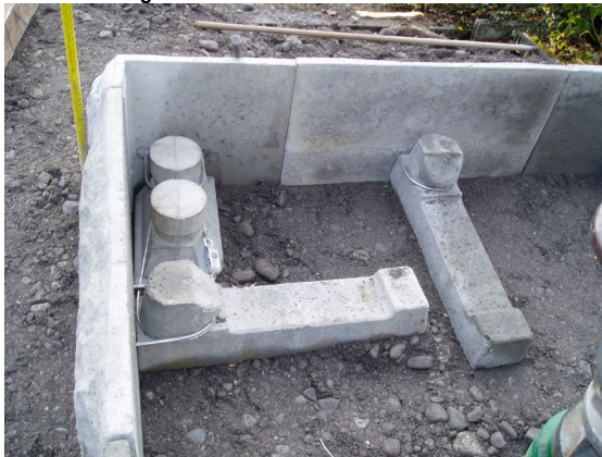
Bild 39: Eckstein mit Eckanker und -spanner
