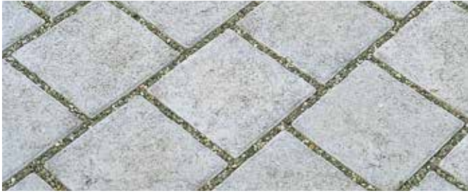
Versickerung durch aufgeweitete Fugen (Splittfuge)
