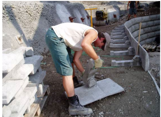
Bild 15: Frontplatte mit Anker verbinden
