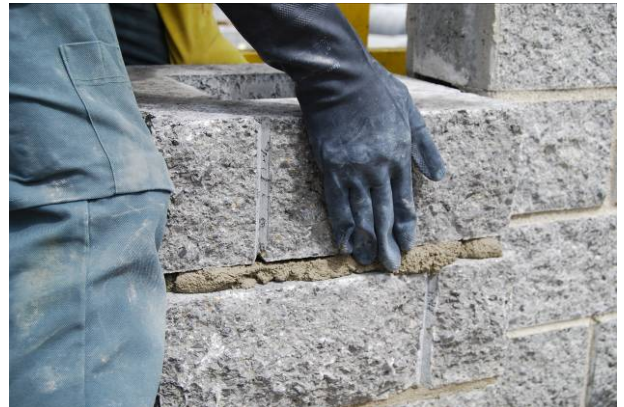
Bild 59: Versetzen von Pfeilerspaltsteinen
