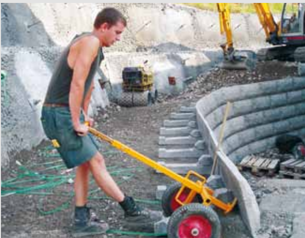
Einfaches Versetzen mit Handwagen
