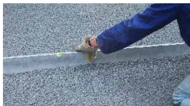
Figure 6 : nivellement du lit de pose
