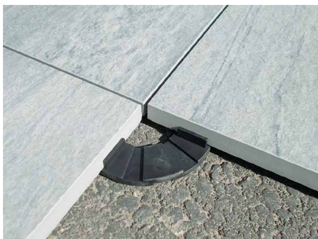
Figure 11 : pose de dalles de jardin en grès cérame sur des anneaux d'appui.
