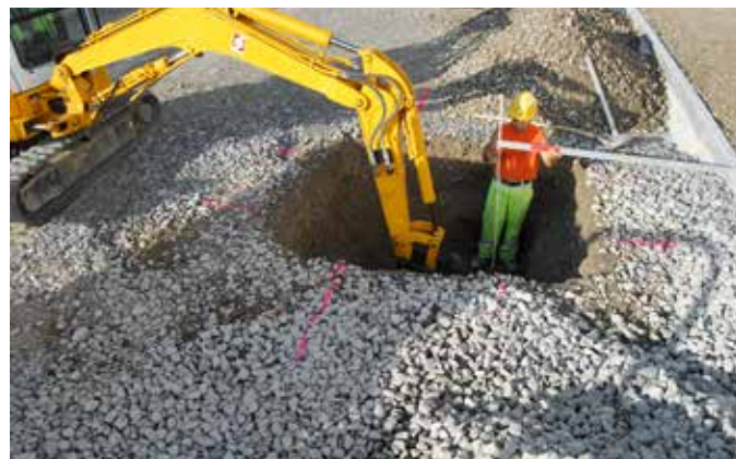
Erstellen des Pflanzloches
