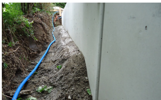
Bild 26: Erstellen der Fundamentnocken
