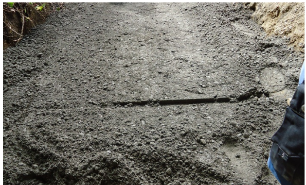
Bild 23: Erstellen des Streifenfundamentes
