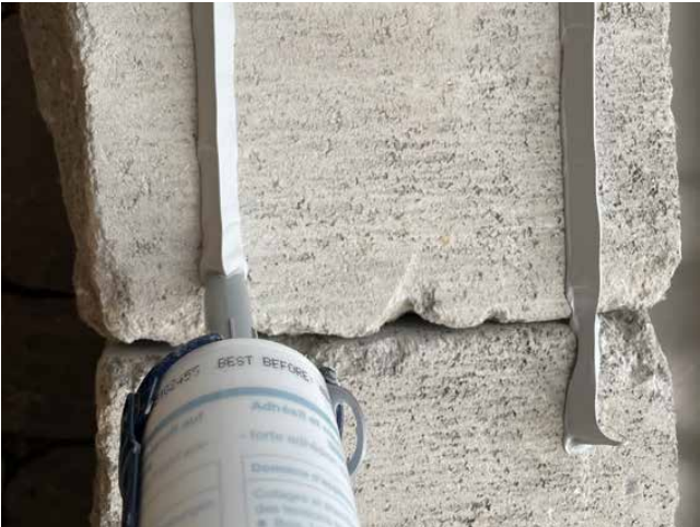
Illustration 3 : Positionnement correct de la buse
