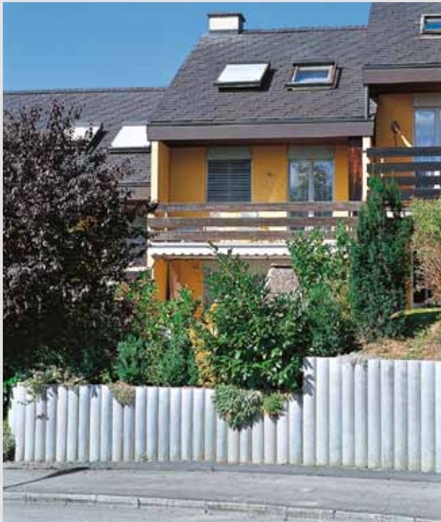
Beton-Palisaden als Hangsicherung.
