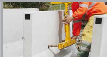
APPAREILS DE POSE POUR ÉQUERRES DE QUAI
