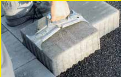
Werkzeug zur Handverlegung
