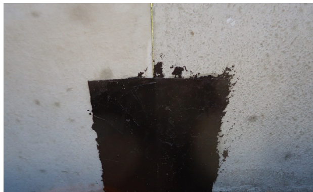
Bild 33: Abdichten der Fugen
