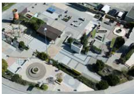
6221 Rickenbach LU, Bohler 5 Permanent zugänglich
