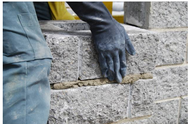
Bild 59: Versetzen von Pfeilerspaltsteinen
