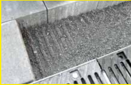
Verkrallung im Pflasterbett
