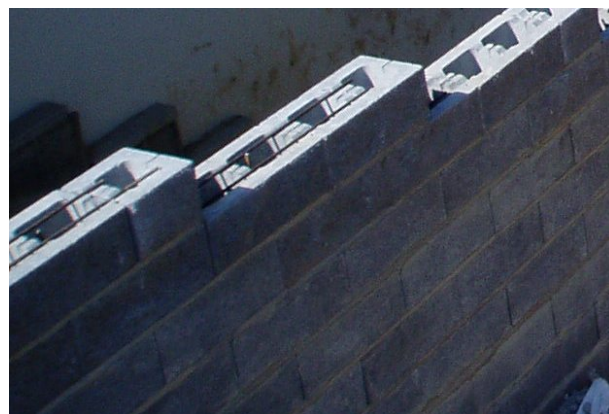
Bild 49: Bewehrungseinlagen, eingelegt in die vorgesehene Nuten
