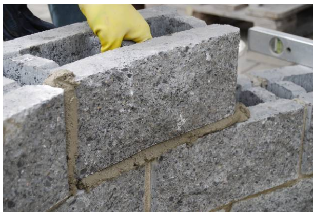
Bild 57: Versetzen von Radiussteinen
