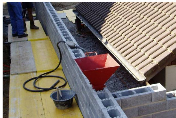
Bild 50: Einbringen von Füllbeton mit einem geeigneten Trichter
