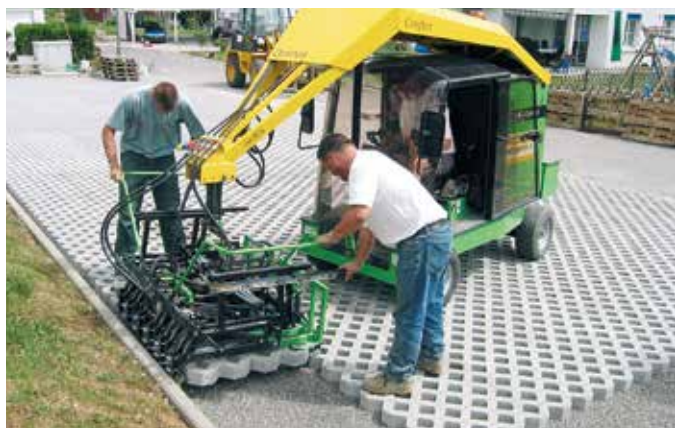
Maschinelles Verlegen mit OPTIMAS-Verlegemaschine
