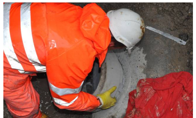
Bild 11: Klebeanschlussstück mit einer Drehbewegung einsetzen
