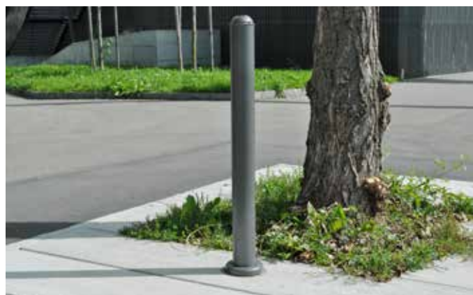
Stammschutzpfahl für sämtliche Betonabdeckungen
