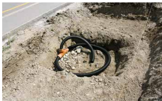
Vorbereitete Sickerrohre in der Baumgrube
