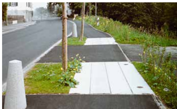
Wurzelbrücke mit Wehrsteinen als Anfahrtschutz
