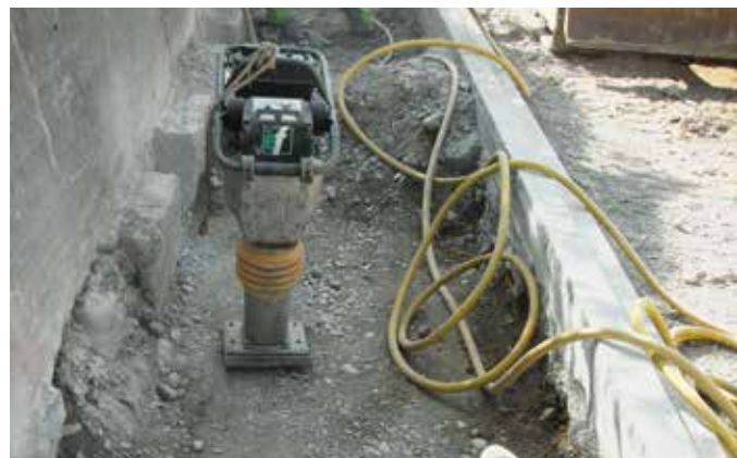
Sohle für die Versetzung der Fundamente
