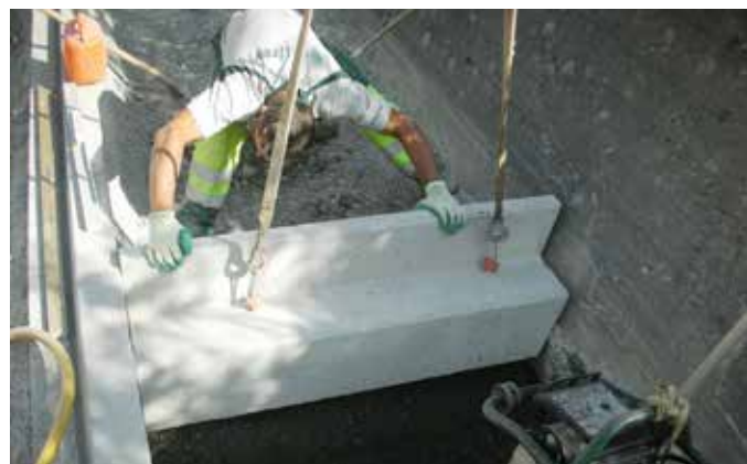
Versetzen des F+F Fertigfundamentes
