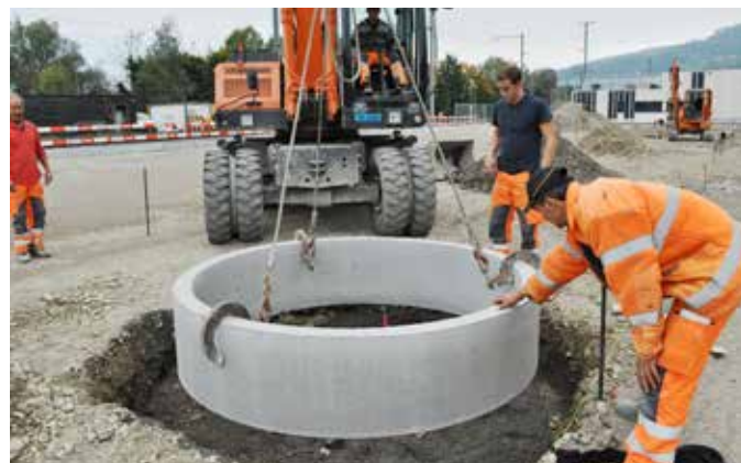
Versetzen des TREETUB Betonrohres auf das Streifenfundament
