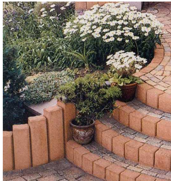
Bild 4: Abtreppungen mit rechteckigen Palisaden
