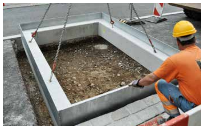
Versetzen des BAUMFIX® Kombirahmenelementes
