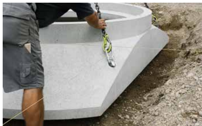
Versetzen des Basiselementes
