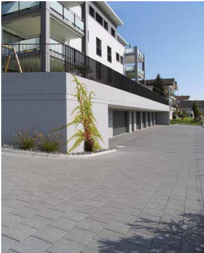
Versickerung durch Sickerstein
