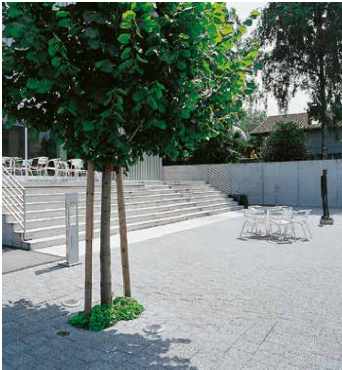
Innenhof mit Sickerstein
