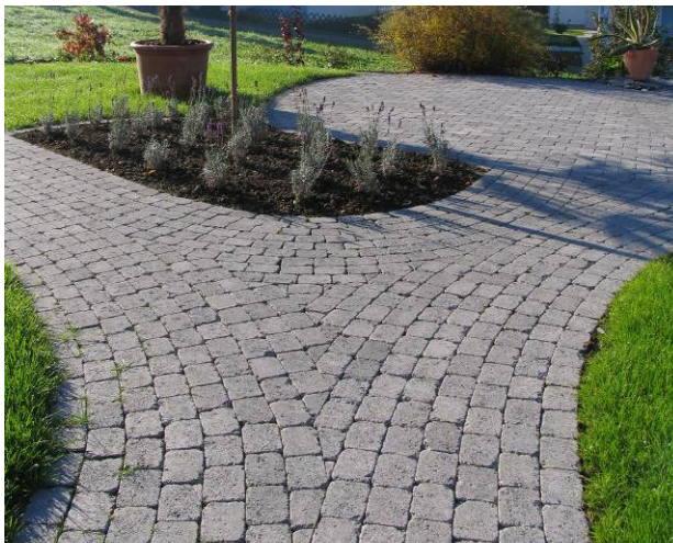
Bild 41: Pflasterfläche mit Passsteinen
