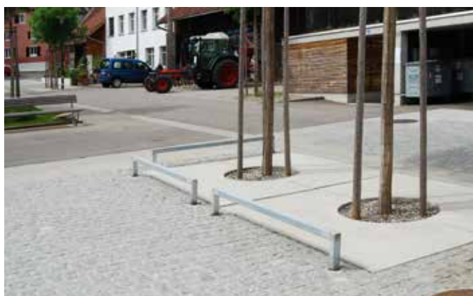
Montierte Radabweiser
