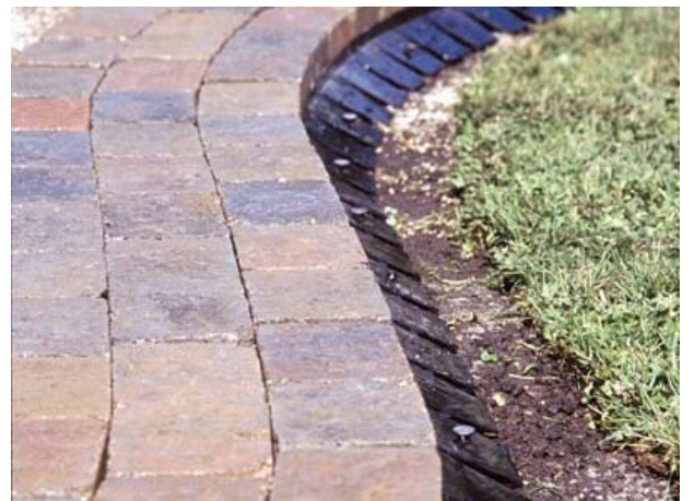
Bild 44: Randabschluss mit PAVE EDGE Randschienen
