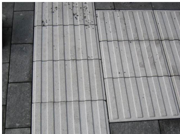
Bild 34: Optimale Fugen bei Steinen H = 8 cm
