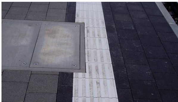
Bild 30: Anpassungen der CARENA® Sicherheitsliniensteine bei Schachtabdeckungen
