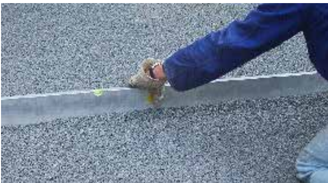
Bild 6: Bettungsschicht abziehen
