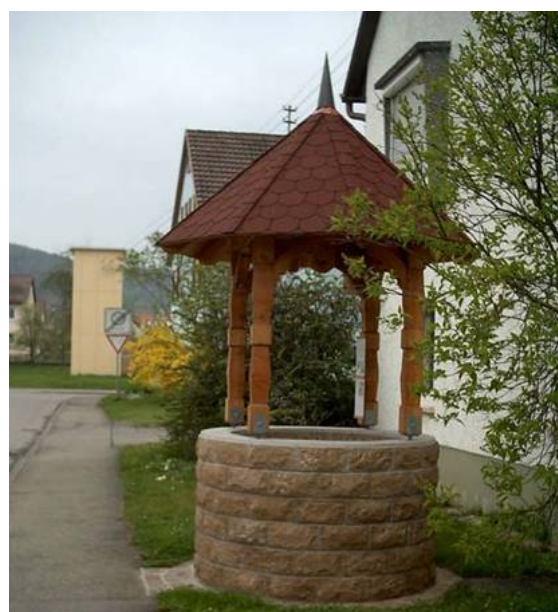
Bild 32: Brunnenbau mit SANTURO® Keilmauersteinen
