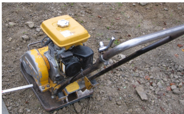
Bild 42: Verdichten nur mit sehr leichten Verdichtungsgeräten
