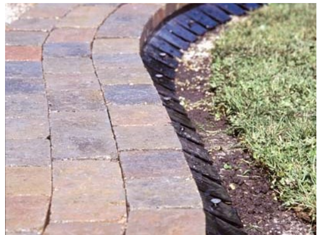
Bild 44: Randabschluss mit PAVE EDGE Randschienen
