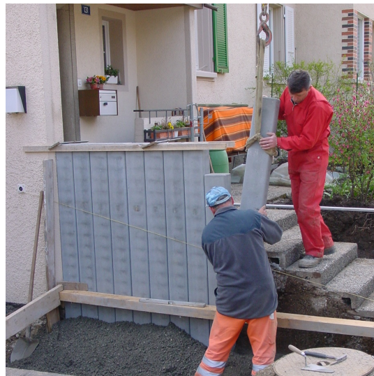
Bild 12: Einbau Palisaden
