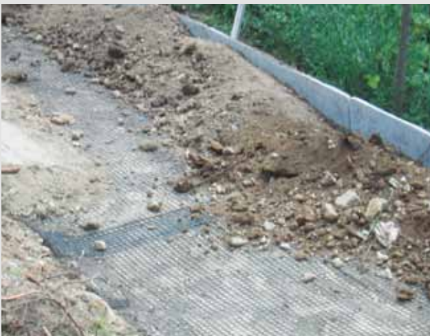
Verlegtes Geogitter
