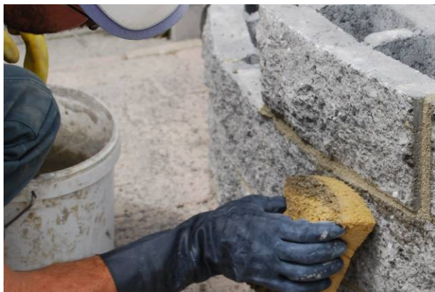
Bild 58: Ausbildung der Mörtelfugen und Reinigung der Mauersteine
