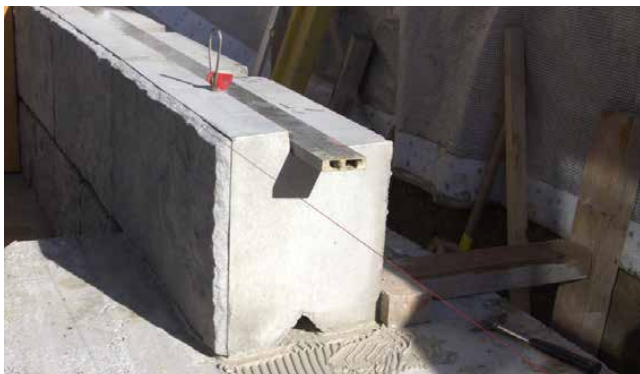
Bild 23 Streifenfundament mit Klebemörteldünnschicht
