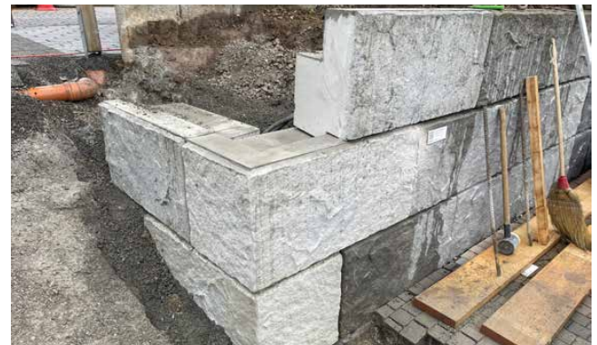
Bild 24 Versetzen der Eckelemente
