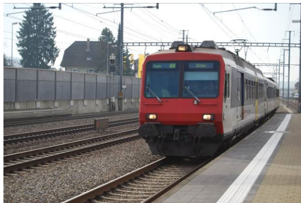
Bild 38: Bahnplattform mit eingebauten CARENA® Sicherheitsliniensteinen H = 6 cm
