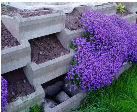
Bild 15: Seitenwände übereinander versetzt
