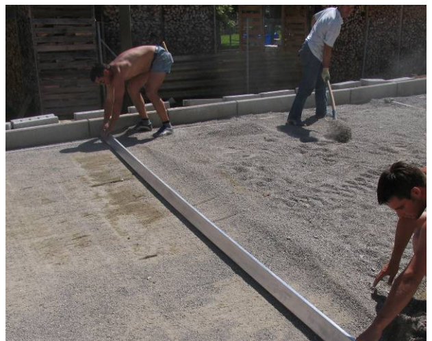
Bild 33: Abziehen der Bettungsschicht
