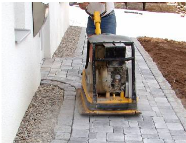
Bild 36: Abrütteln der Pflasterfläche
