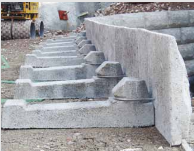
Frontplatten mit Erdanker
