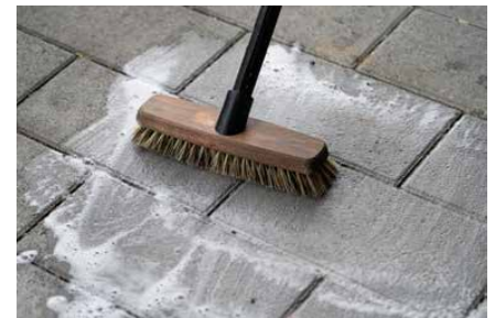
Reinigungsmittel auftragen
