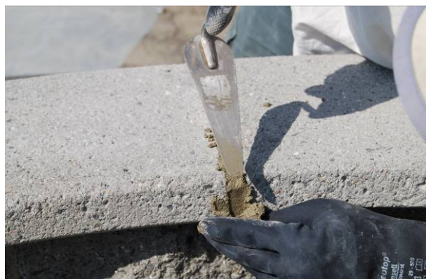
Bild 64: Verfugen der Abdeckplatten
