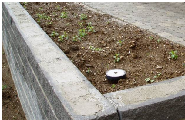
Bild 61: Vorbereitete Mauerkrone
