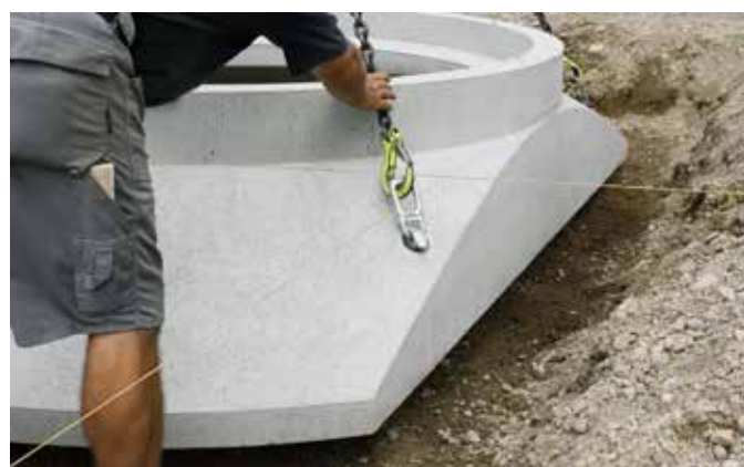
Versetzen des Basiselementes
