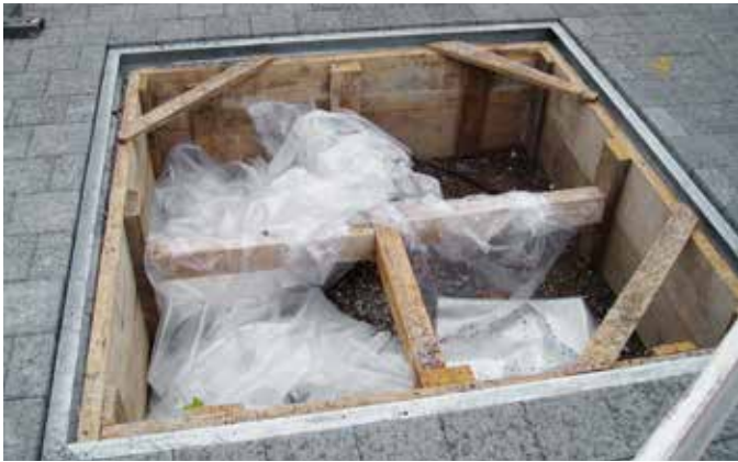
Eingebauter Stahlrahmen als Baumkranz
