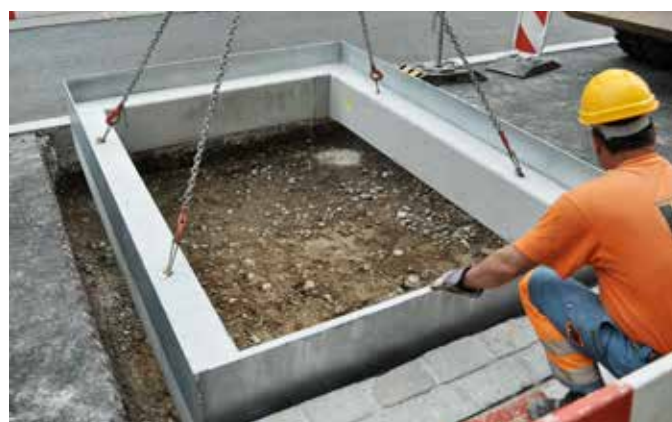
Versetzen des BAUMFIX® Kombirahmenelementes
