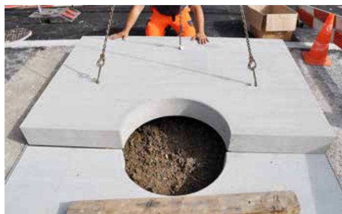
Versetzen der BAUMFIX® Baumscheiben
