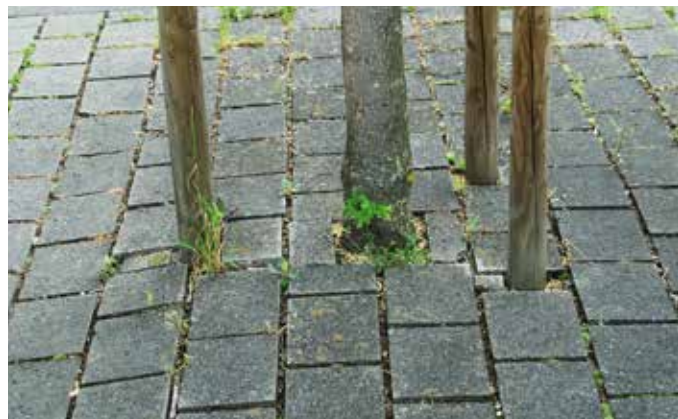
Platzmangel durch Versiegelung der Fläche bis zum Baumstamm
