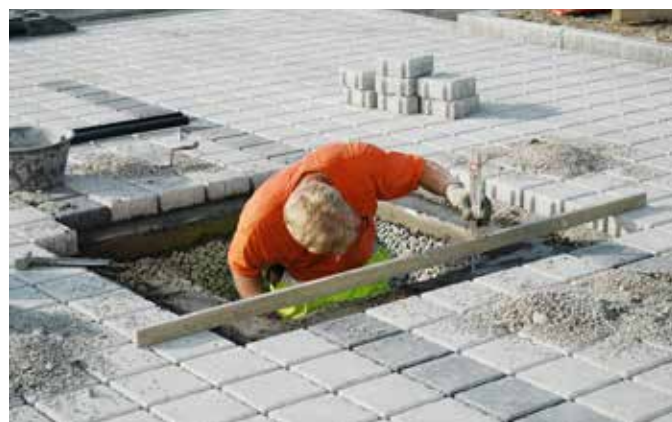
Erstellen eines Auflagers auf Fundamentrahmen
