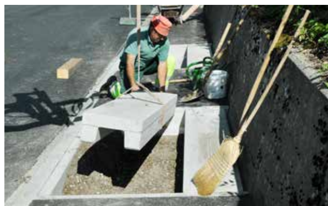
Versetzen der F+F Abdeckelemente
