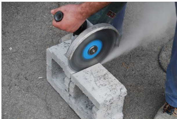
Bild 52: Trennen der Spaltsteine mit Winkelschleifer
